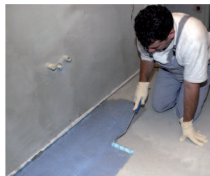
PCI Gisogrund förbättrar vidhäftningen, binder dammpartiklar, förlänger öppentiden för avjämningsmassor och fästmassor mot för snabb uttorkning.
