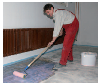
Outspädd PCI Gisogrund Rapid läggs i ett jämnt tjockt lager på mineralunderlaget med en fin skumroller. När PCI Gisogrund Rapid har bildat en film på underlaget kan efterarbetet påbörjas omedelbart.
