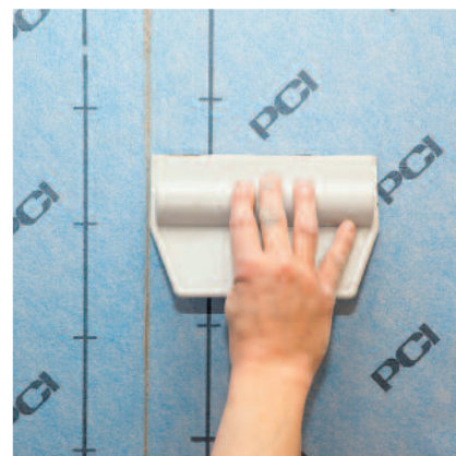
Folieväderna monteras kant i kant i det blöta Lastogummskiktet.
