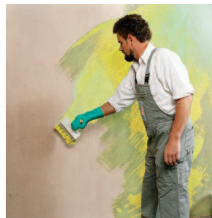
PCI Wadian, tunn gulfärgad tätskiktsdispersion med hög ångtäthet, påføres i 2 skikt.
