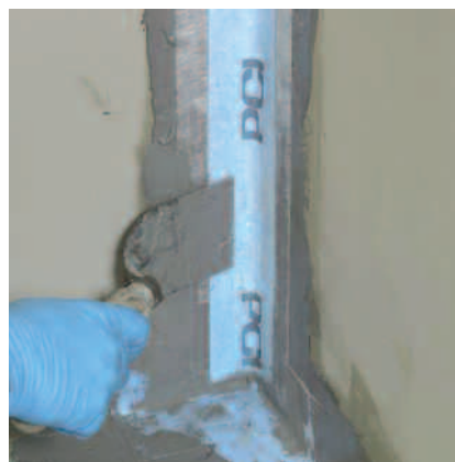
Täta med tätremarna PCI Pecitape i hörnen.
