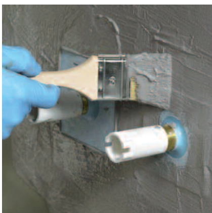
Förankra tätmanschetterna PCI Pecitape 10,5x10,5 (Ø10-24).
