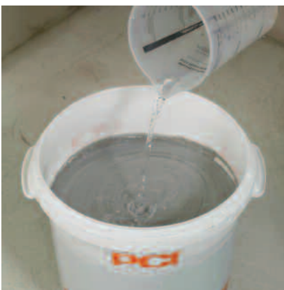
För strykning, tillsätt rätt mängd vatten (1 b).
