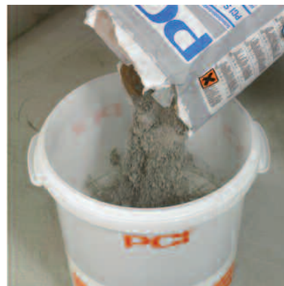
Tillsätt PCI Seccoral 2K Rapid-bruk.
