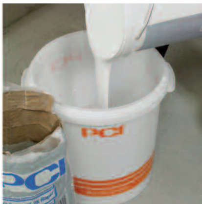
Häll våtdelen av PCI Seccoral 2K Rapid i ett rent blandningskärl.
