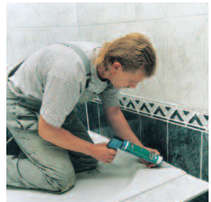
Mjukfogar utföres med PCI Silcoferm S.
