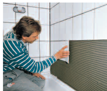
PCI FT Extra ger glidfri sättning, har bra "häng" som gör plattsättningen snabb och enkel.
