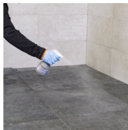
Före den avslutande rengöringen av plattorna ska PCI Durapox Finish (flytande) sprayas på ytan efter ca 60 min.
