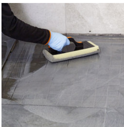
Efter 10 - 45 minuter ska den fogade ytan grovtvättas med en svampbräda och sedan fintvättas ren.
