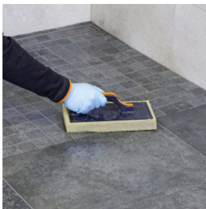
Använd därefter en ren svampbrädan för att torka bort restsiktet så att plattorna blir rena.
