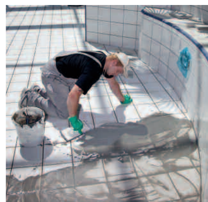
PCI Durafug NT används för fogning av keramiska plattor som utsätts för hög mekaniskbelastning runt om och i bassänger.
