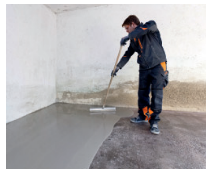
Utjämning av hela golv med lättflytande PCI Zemtec Outdoor för direkt användning.
