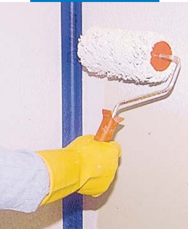
Applicering med roller
