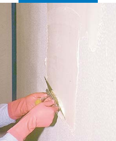
Applicering av fästmassa på Mapegum WPS
