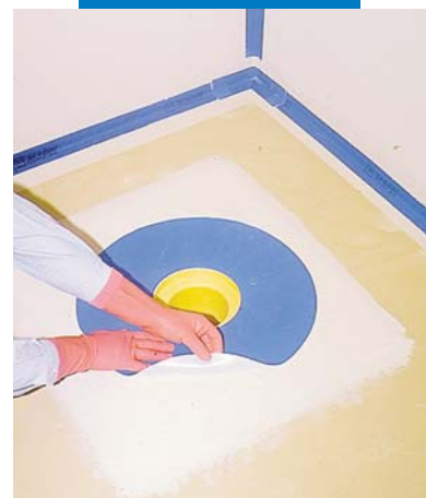
Montering av godkänd golvbrunnsmanschett enligt respektive nationell standard
