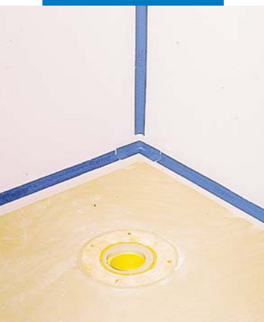
Badrumsvägg vattentätad med Mapegum WPS och Mapeband
