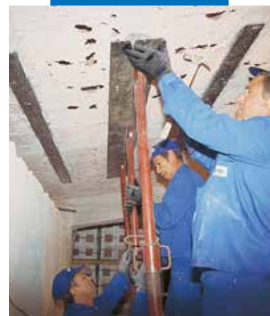
Placering av metallskiva för förstärkning av konstruktion
