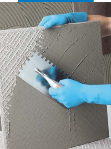
Applisering av fästmassan på baksidan av plattan
