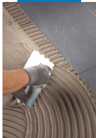
Applicering av fästmassan på golv med 9 mm halvrundad tandspackel
