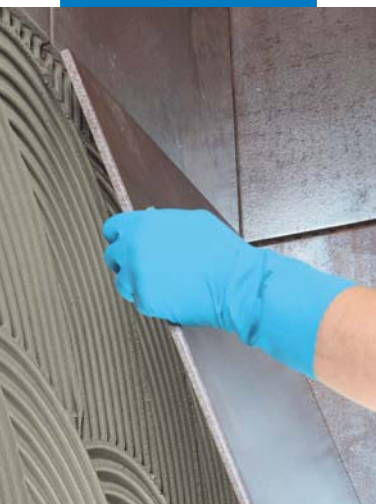
Sättning av stora plattor på väggar
