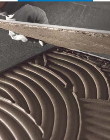
Läggning av tunn porslinskeramik på golv
