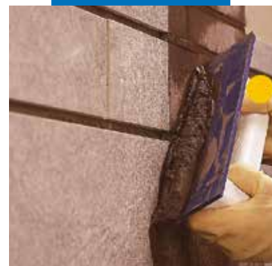
Påföring av Ultracolor Plus på vägg med gummispackel
