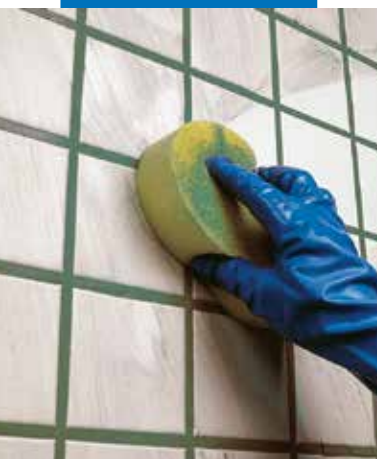
Rengöring och slutbehandling av plattfogar på vägg med svamp
