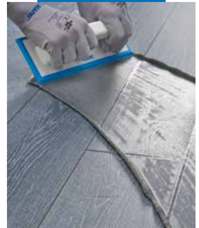
Fogning av Ultracolor Plus med gummispäkel på klinker med trä-struktur
