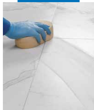
Rengöring och slutbehandling av plattfogar med cellulose svamp
