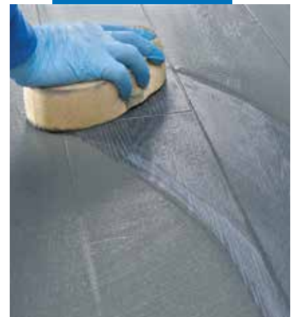
Rengöring och efterbehandling av kakelfogar med hård cellulosasvamp
