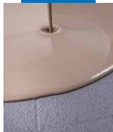
Applicering av Ultraplan självutjämnande avjämningsmassa över torr Eco Prim Grip på gammalt golv
