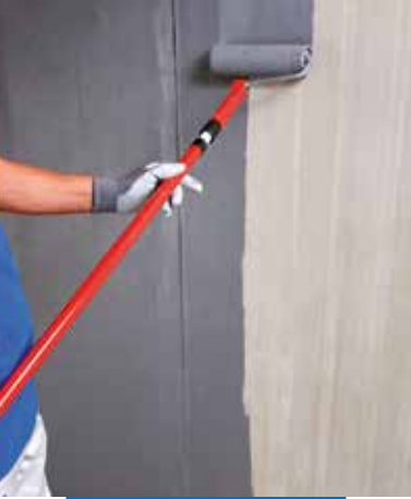
Applicering av Eco Prim Grip på betong med roller
