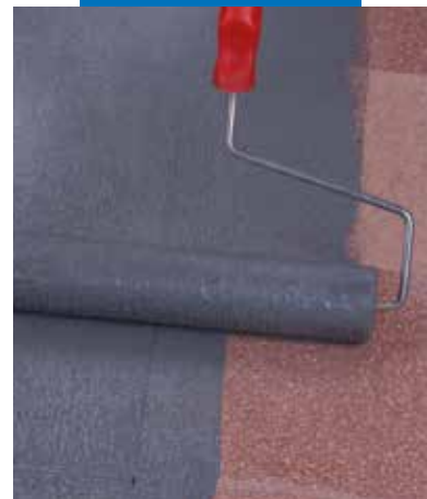
Applicering av Eco Prim Grip med roller på befintligt terrazzogolv
