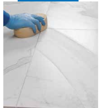
Rengöring och slutbehandling av plattfogar med cellulose svamp
