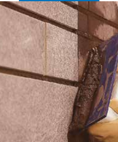
Påföring av Ultracolor Plus på golv med gummiraka
