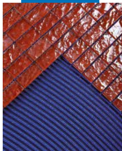
Foga följande dag med Kerapoxy Design i samma kulör och enligt samma metod som tidigare beskrivits
