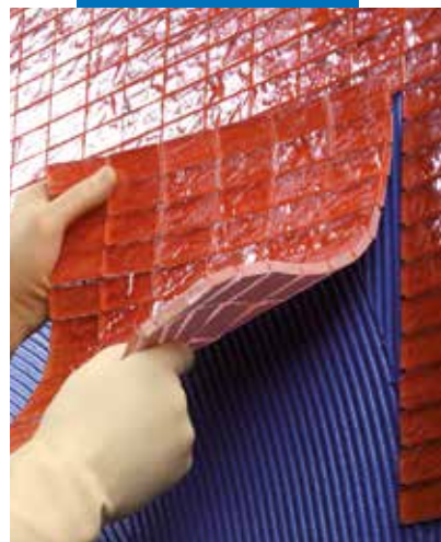
Montering av mosaik på vägg med Kerapoxy Design
