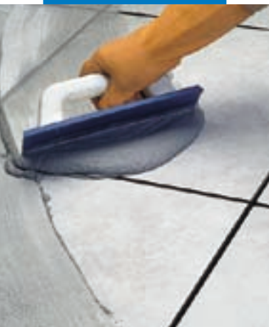
Fogning av keramiska plattor på golv med gummispackel
