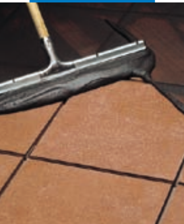
Fogning av terracottaplattor på golv med gummiraka
