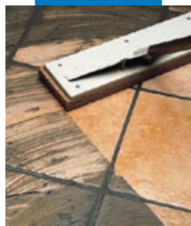
Rengöring av enkelbrända plattor med svampplatta
