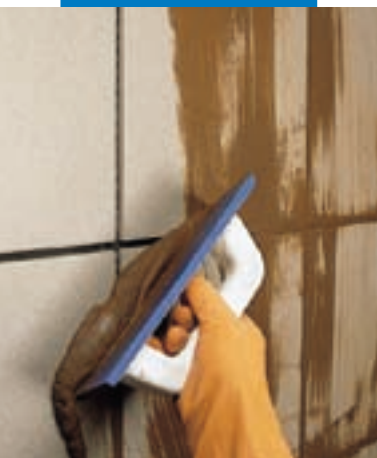
Fogning av utvändigt vägg med gummispackel
