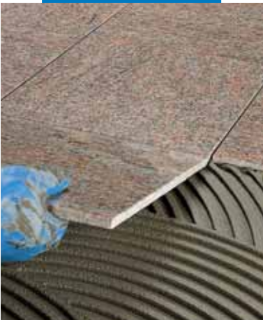
Installation av förpulerad marmor på golv
