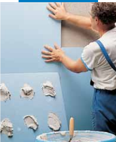
Fläckvis limning av polystyrenpaneler med Keraflex vit
