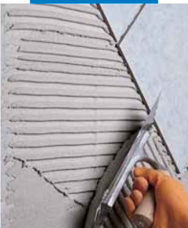
Montering av granitkeramik på lättbetongvägg
