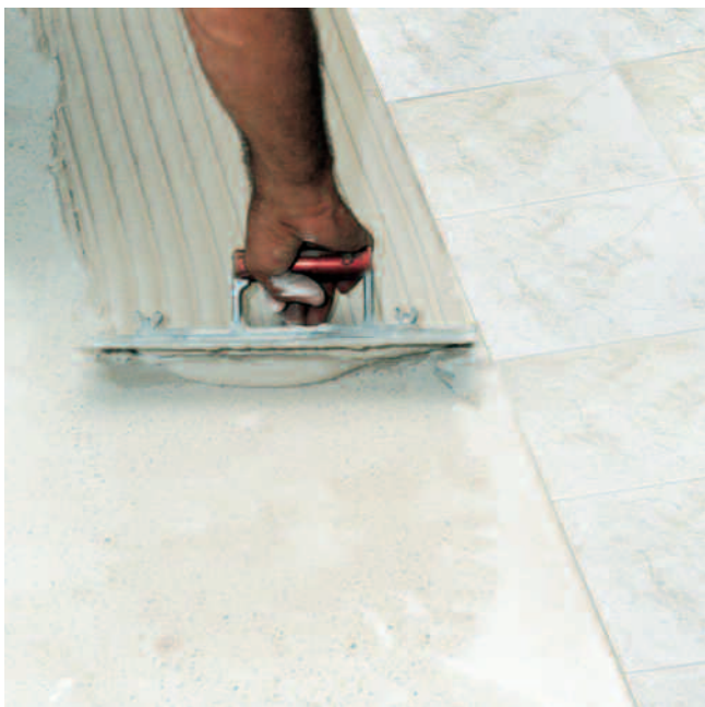
PCI Carrament är ett plastiskt och smidigt fästbruk, som är enkelt att fördela.
