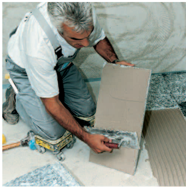
Dubbellimma naturstenen vid läggning utomhus, så att full kontakt erhålles och inga hålrum bildas under stenen.
